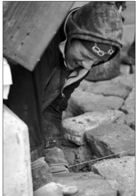
Steine verlegen ist harte Arbeit
