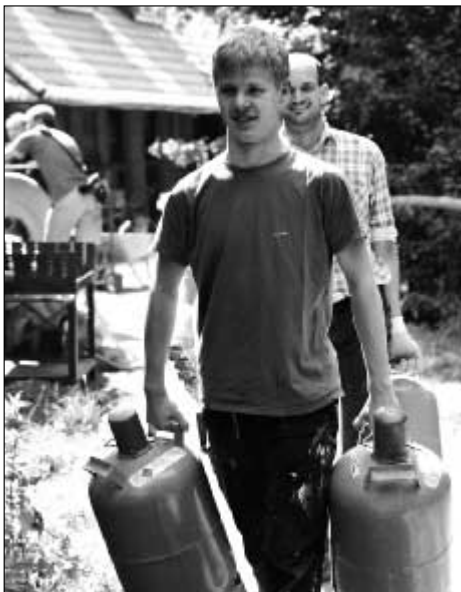
Nachschub zum Verschweißen von Bitumenbahnen wird aus allen Ecken hergeschafft.
