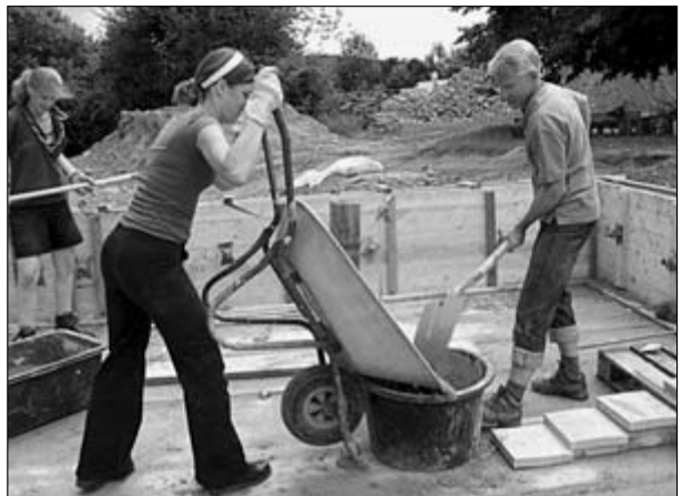
Packte während der Bauarbeiten mit an: MdL Dirk Landau (rechts)
