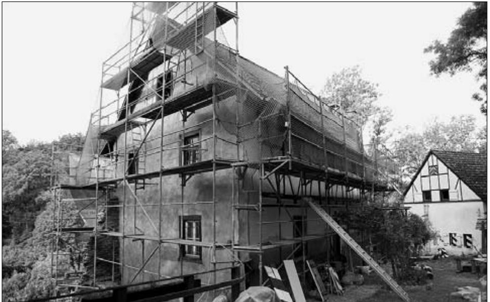
Hohenkrähen, eingerüstet zur Dachsanierung
