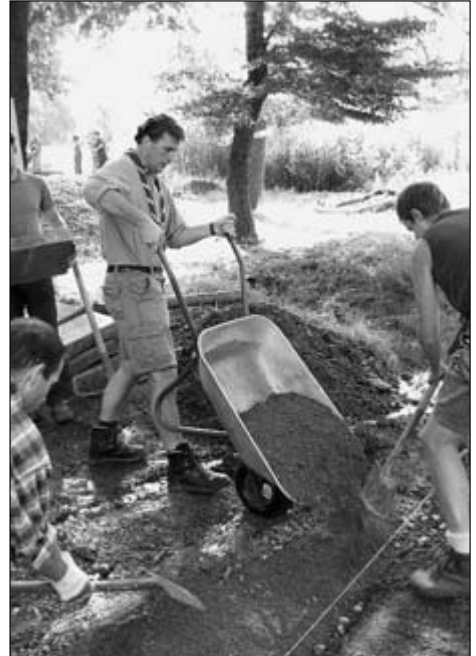
Arbeiten im Außenbereich des Pumpenhauses
