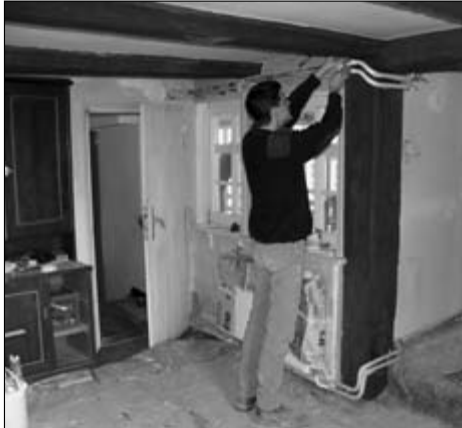
Ottokarl baut alte Kabelzuführungen ab
