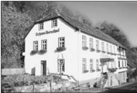
Bild 2: Der letzte Zeitzuge: das alte Bergamt. Alle anderen Gebäude wurden durch einen Bergbruch 1907 stark beschädigt und abgerissen (Foto 2005)
