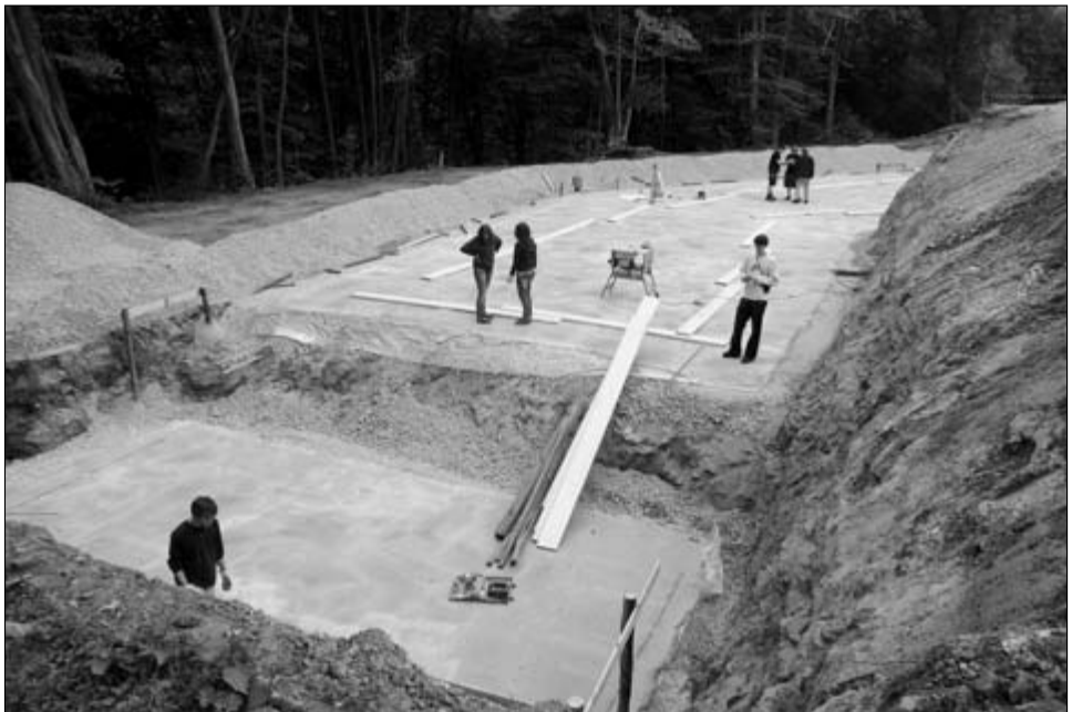
Teilansicht der Beton-Bodenplatte des Enno-Narten-Baus
