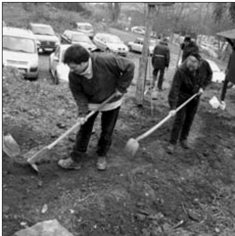
Erneuerung des Weges vom Parkplatz zur Burg
