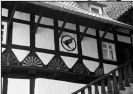
Freitreppe im Innenhof
