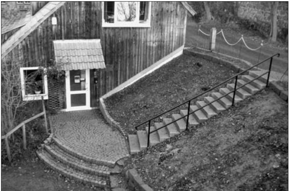
Die neuerstellte Archivtreppe
