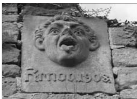
Der 1908 renovierte „Neidkopf“ am Hanstein (zwischen dem 3. und 4. Burgtor)
