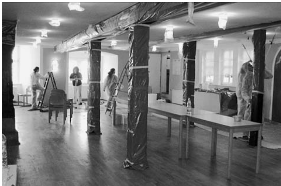
Renovierung des Speisesaals
